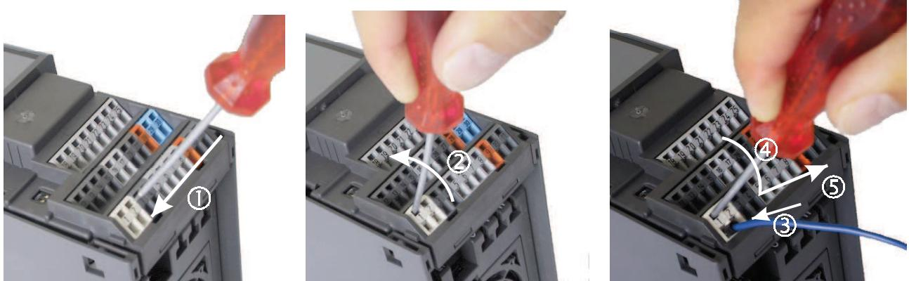
Obr. 15 Postup při upevnění vodiče v řídicí svorkovnici
